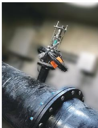
φ1200Aセンサ挿入作業中
