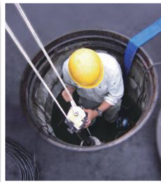
φ1200Aセンサ挿入作業中
