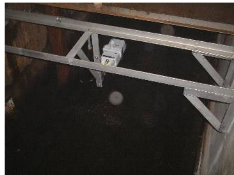
センサ側：水路に金具を渡して設置
