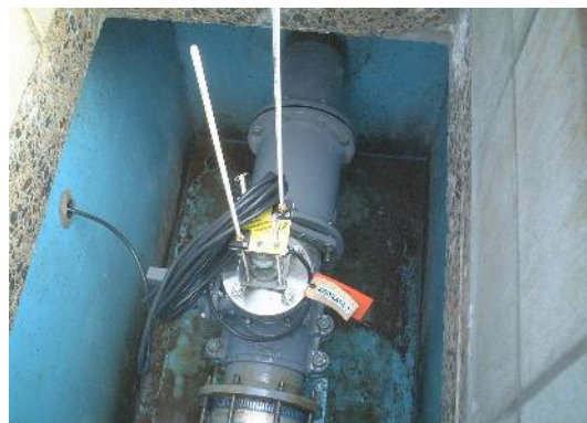
設置後ピット内部
