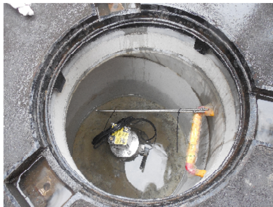
水没するピットでの使用例②
