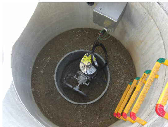
2号マンホールピット
