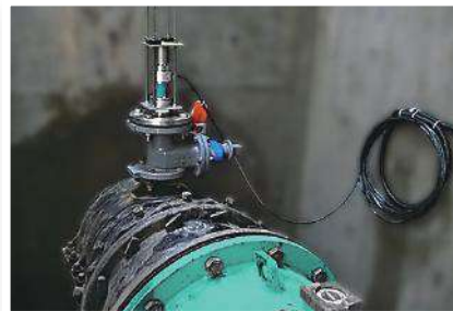
古いバイパス管は使用せず不断水で電磁流量計を更新
