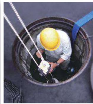
↑1200Aセンサ挿入作業中 ↳新設配管への設置
