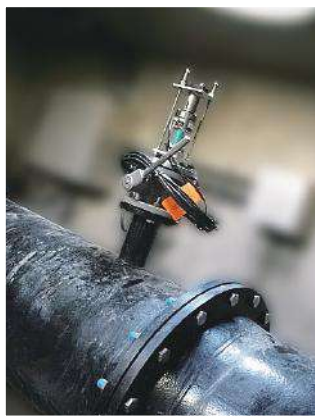
↑1200Aセンサ挿入作業中 ↳新設配管への設置
